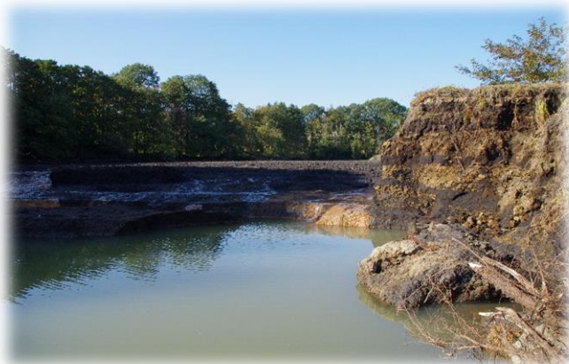
向溜の決壊した堤体部分から池内を望む
